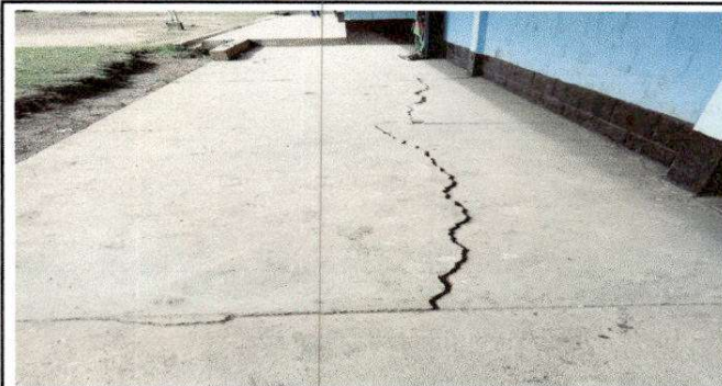
Foto 4: Reparación de planchas de concreto, de patio
