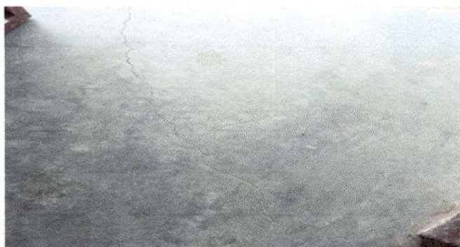
Foto1: Sustitución de piso de cemento líquido (por cerámico)
