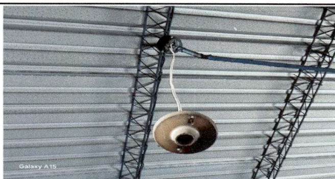
Foto 5: Sustitución de focos ahorradores y plafoneras
