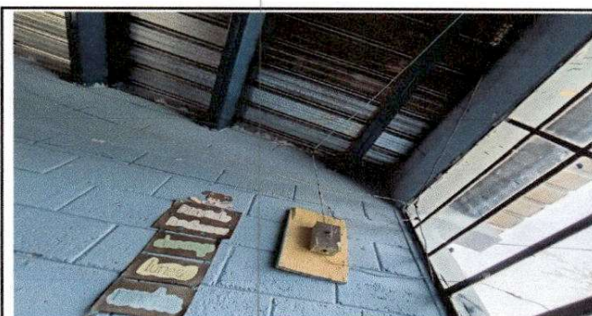
Foto 6: Reparación de cableado eléctrico
